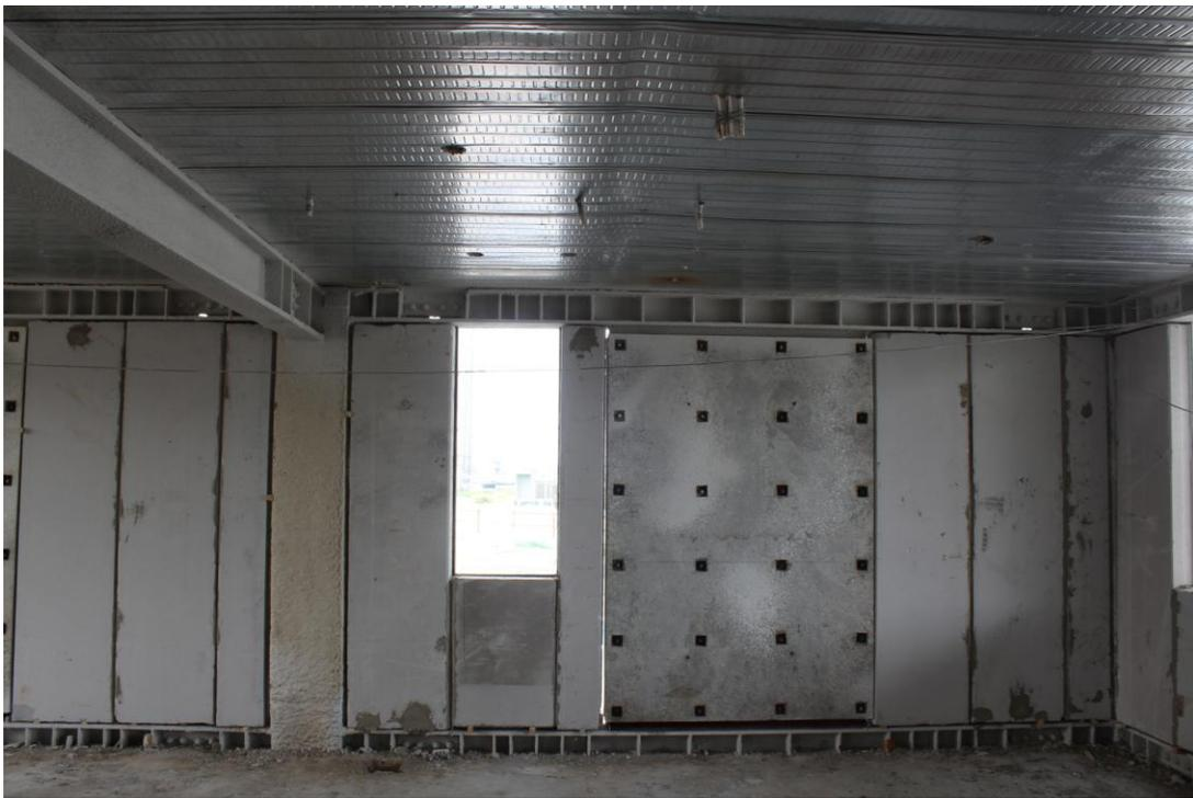
**钢框架-防屈曲剪力墙结构体系：**钢柱采用矩形钢管混凝土柱，内灌自密实混凝土，抗侧力构件采用防屈曲钢板剪力墙，防屈曲钢板剪力墙与主体结构采用两边约束形式，与钢梁上下连接。
