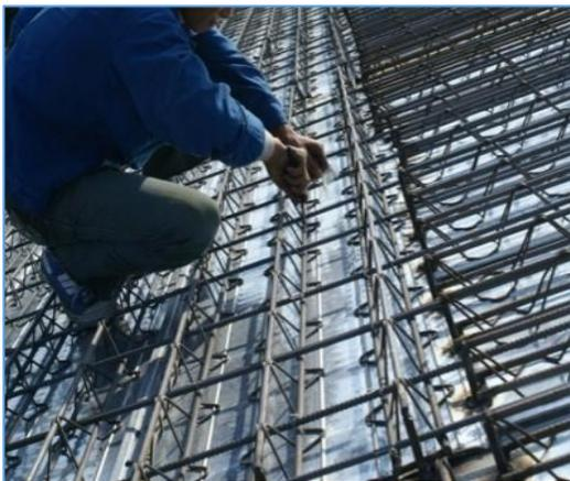
钢筋桁架板
