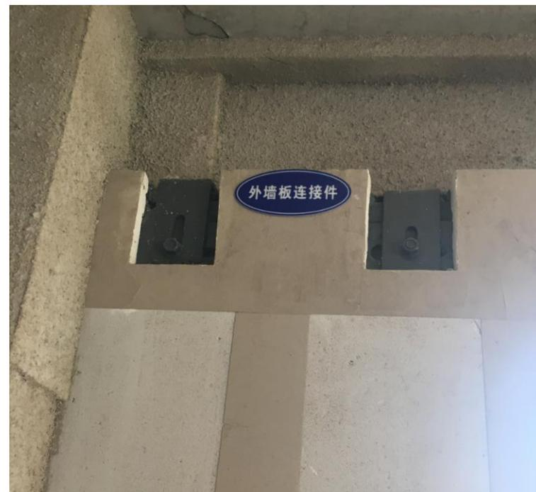
**连接形式：**ALC板与主体结构采用柔性连接技术，外墙板内嵌于主体结构柱梁之间，采用可滑动易操作的柔性连接节点，保证高烈度地区高层建筑外墙板的安全性。
