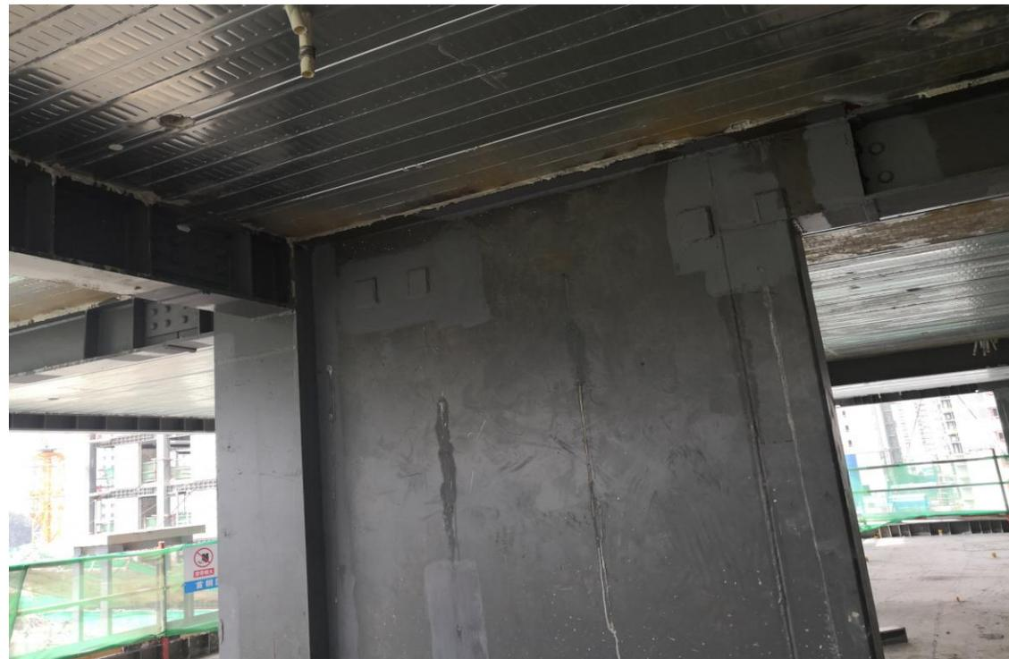
**钢框架-组合钢板剪力墙结构体系：**钢柱采用矩形钢管混凝土柱，内灌自密实混凝土，抗侧力构件采用组合钢板剪力墙，钢梁与组合钢板剪力墙刚接。
